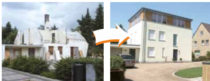
Neues Wohngeschoss im OG, Dachaufstockung und umfassende Hausmodernisierung
