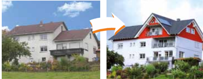
Dachaufstockung mit großem Quergiebel
