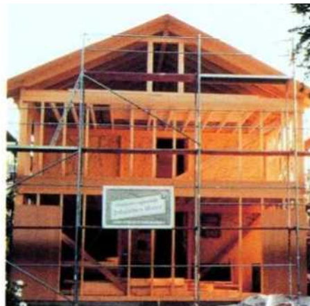
Phase 2: Giebelseitiger Anbau in Holzkonstruktion
