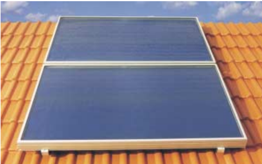
Bild 9 Flachkollektor in aufdach Montage
