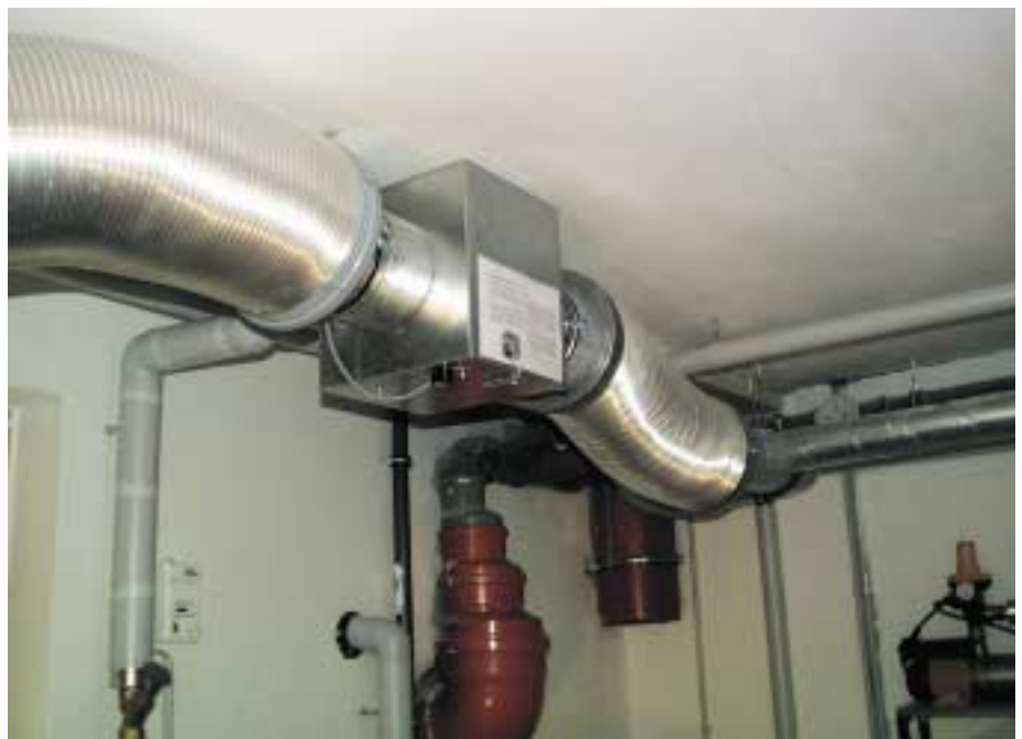
Bild 39 Stromeffizienter Abluftventilator mit Schalldämpfern für die Abluft und Fortluft.
