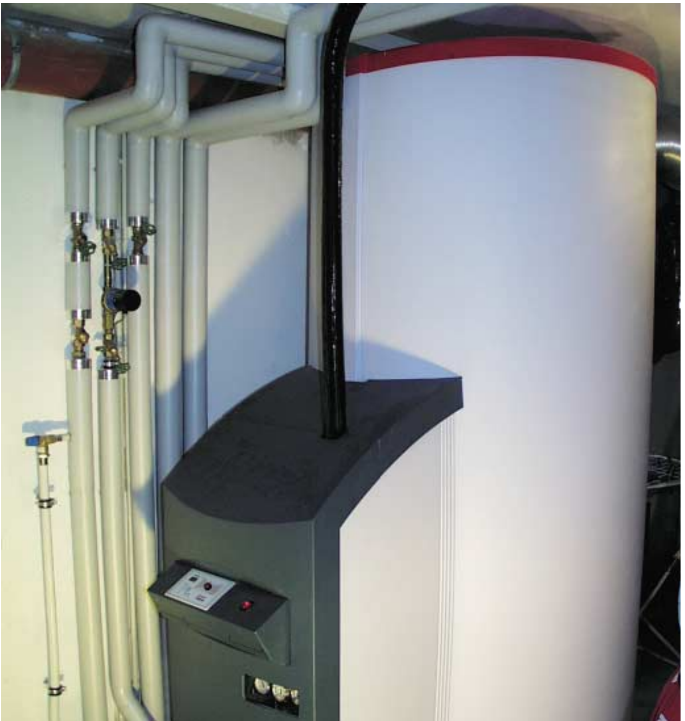
Bild 40 Solar-Schichtenspeicher mit integrierter Solarstation und Warmwasserbereitung über einen Plattenwärmetauscher.
