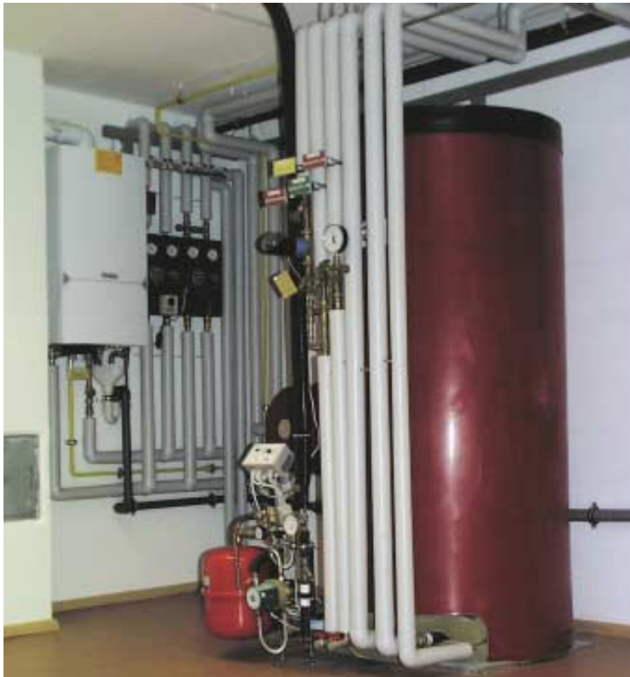
Bild 43 Schichtenspeicher mit Solarstation und Gasbrennwertgerät.
