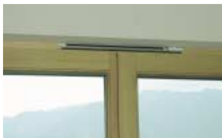
Bild 25 Zuluftventil für den Fenstereinbau mit thermostatischer Regelung als Schemazeichnung und im eingebauten Zustand.
