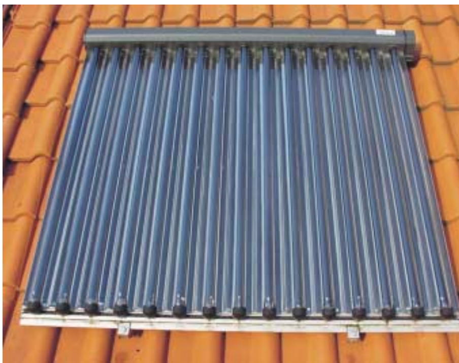
Bild 8 Vakuum-Röhrenkollektor mit Doppelglasröhre und CPC-Spiegel zur Nutzung des reflektierten Lichtes.
