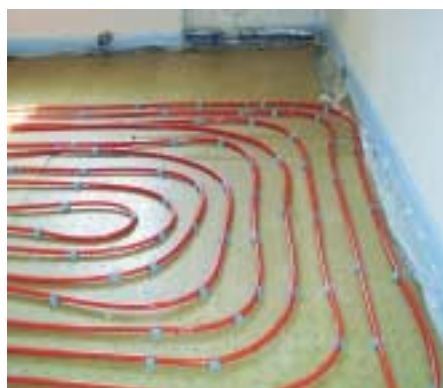
Bild 17 Fußbodenheizung mit Kunststoffrohren auf einer Biofaser-Trägerplatte für Estrichverlegung.
