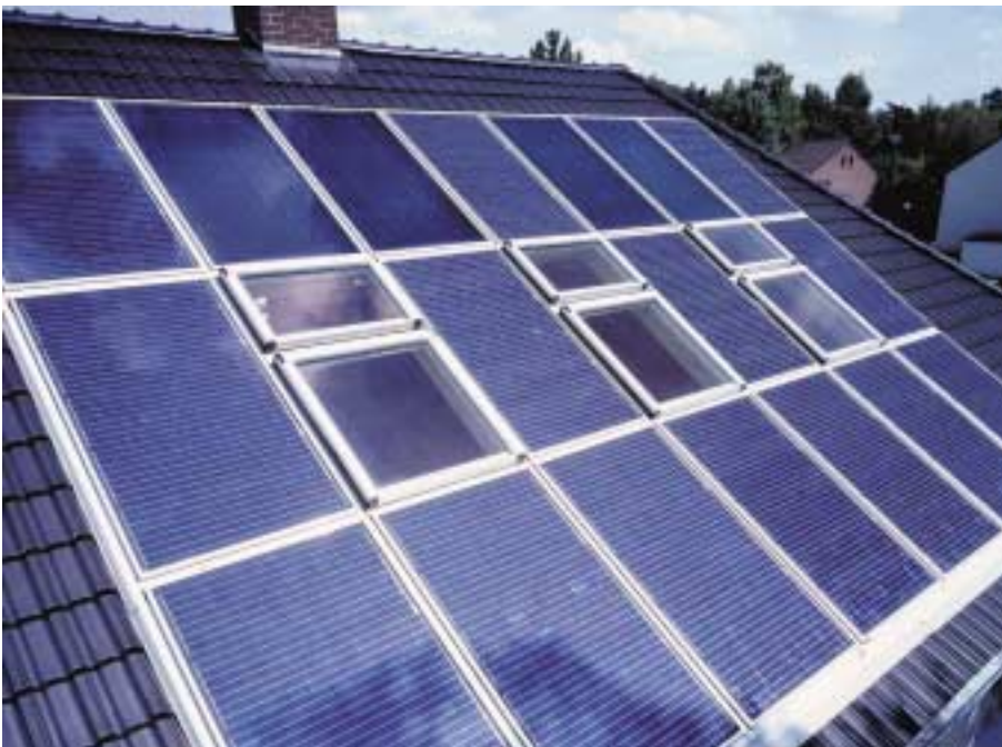
Bild 10 Ganzdachlösung mit Sonnenkollektoren, Solarstrommodulen und Dachflächenfenstern.
