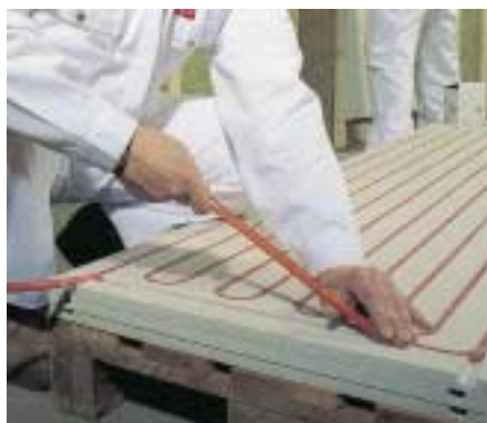
Bild 20 (links) Vorgefertigtes Wandheizungssystem mit Kunststoffrohr.
